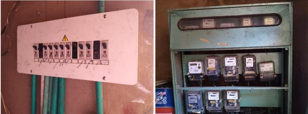
La instalación eléctrica interna del Conjunto Residencial refleja la inexistencia de un programa de mantenimiento preventivo y correctivo, indispensable en cualquier instalación eléctrica. Respecto a la instalación interna se observó lo siguiente:
