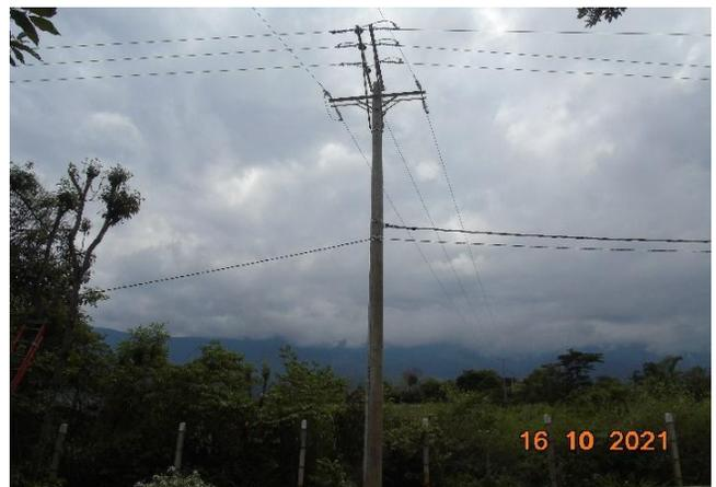
**Estructura de conexión con la red de CENS a 13,2 KV**
