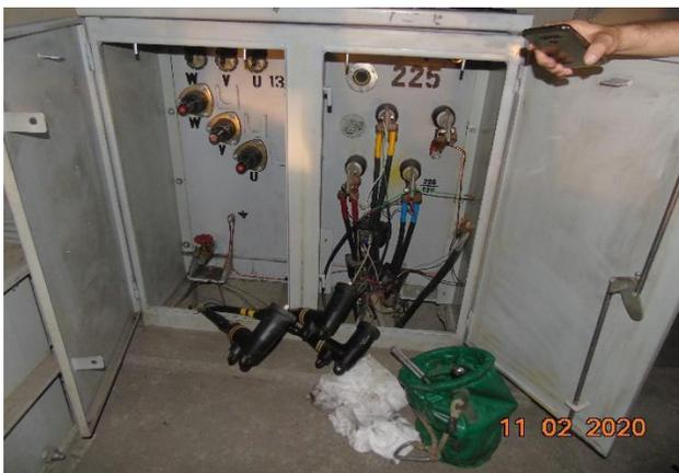
**Desconexión del transformador para realización de pruebas**
